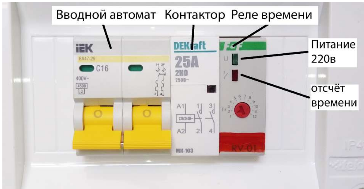
Рис.4 Элементы блока управления.
